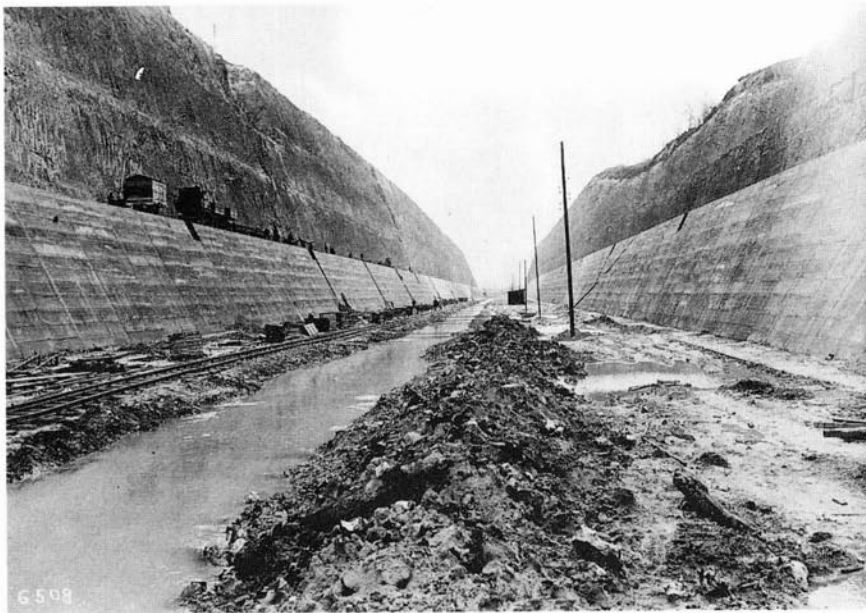
FIGUUR 17. Ten behoeve van de aanleg van het Albertkanaal werd een grote sleuf door de Cannerberg en de Sint Pietersberg gegraven. Deze zg. Tranchée de Caestert vormt voor veel soorten een onoverbrugbare barrière. Datum foto: 18 april 1934.
