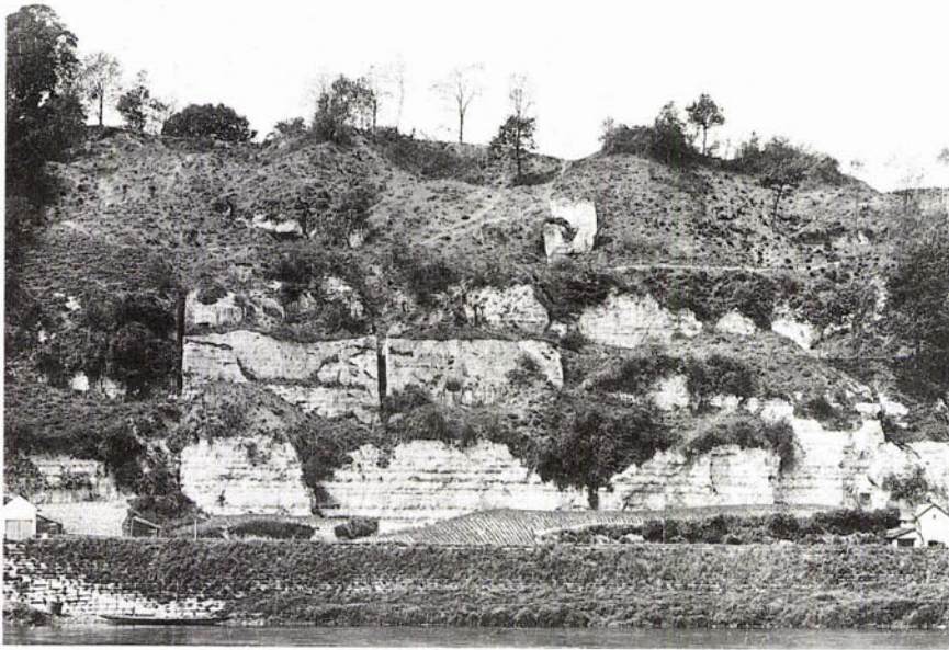
FIGUUR 13c. Ten behoeve van de aanleg van het kanaal Maastricht-Luik (1845) werd het deel van de oosthelling van de berg tussen Lichtenberg en Petit-Lanaye afgegraven. Hierdoor ontstond een steile kalksteenwand waarvan de natuur later weer bezit nam. Het tussen Lichtenberg en de Rijksgrans gelegen deel werd na de aanleg van de E.N.C.I.-groeve nog een tijdje gehandhaafd en stond toen bekend als de "coulisse". Foto: ca. 1900, kollektie B. Graatsma.
